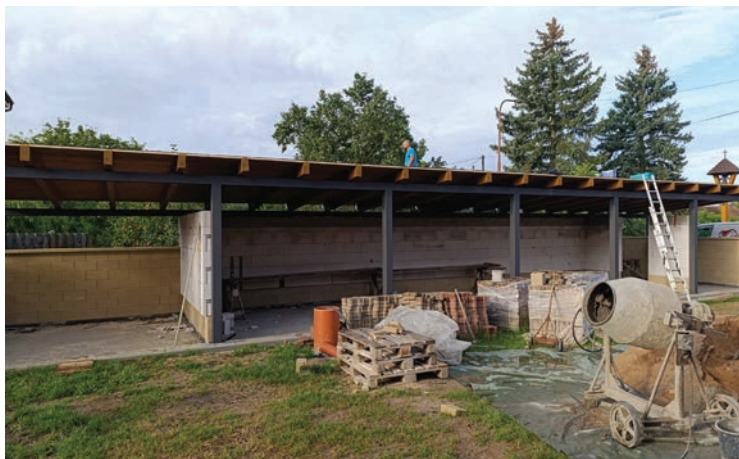
▲ Stavba probíhala od července do října. Foto: Jana Pečenková
